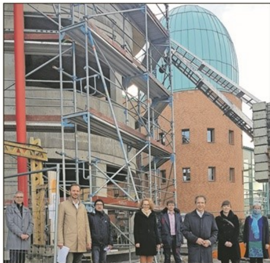
Der halbrunde Anbau an die Grundschule Cité orientiert sich am Turm des Familienzentrums (rechts). Foto: Fricke
