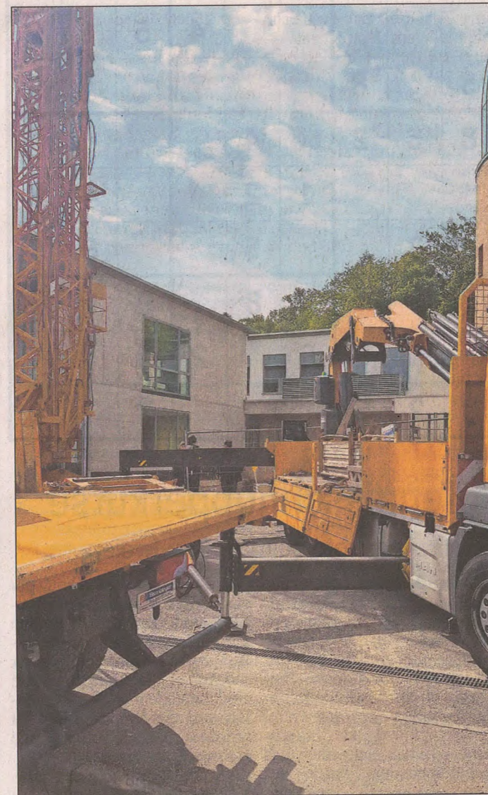
Der Kran steht bereit. Der Gebäudeflügel links im Bild soll erweitert werden.
